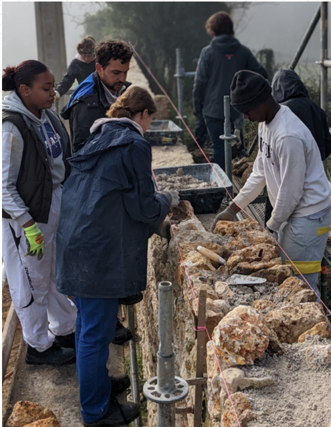
Reconstruction du mur d'enceinte de la Bergerie nationale
