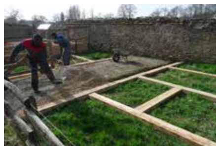
Aménagement de la nouvelle plateforme avec la participation de Denis et Martial, stagiaires sur l'exploitation agricole.
