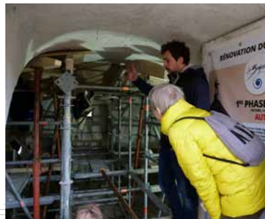
Le soubassement du colombier a été renforcé pour sécuriser les travaux de la salle principale.
